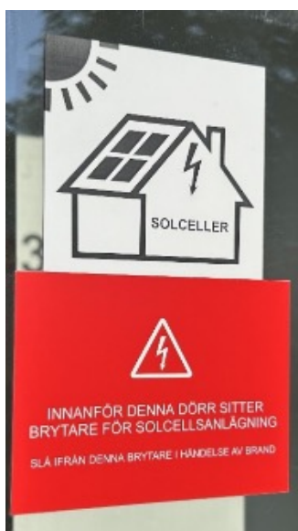
Figur 4 S skyltning utanför entré där manöverdon till DC-brytare är placerad
